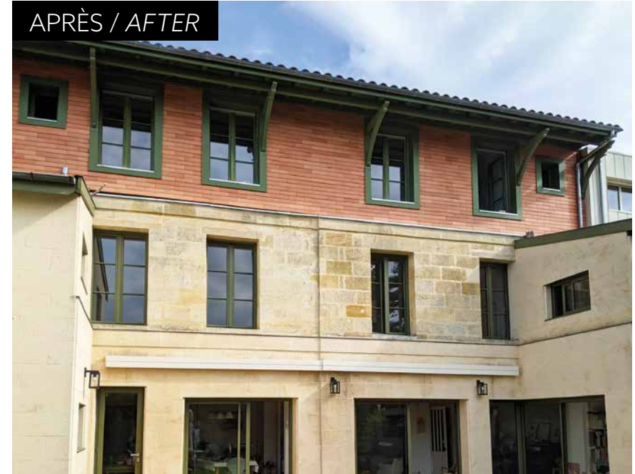
Surélévation à Bordeaux en ossature bois sans bureau de contrôle Roof lift in Bordeaux with a wood framework (not approved by a design office)
