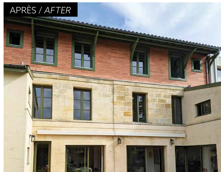
Surélévation à Bordeaux en ossature bois sans bureau de contrôle Roof lift in Bordeaux with a wood framework (not approved by a design office)
